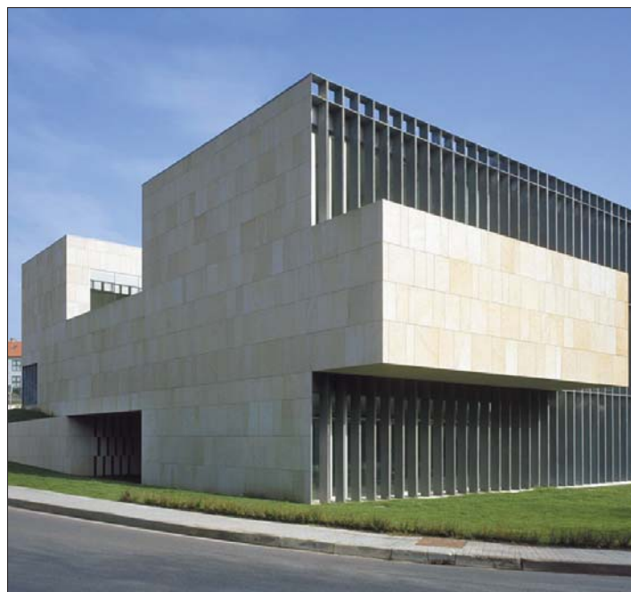
En la imagen, el Centro de Formación en Nuevas Tecnologías de Galicia, cuya sede se encuentra situada en Santiago de Compostela.
